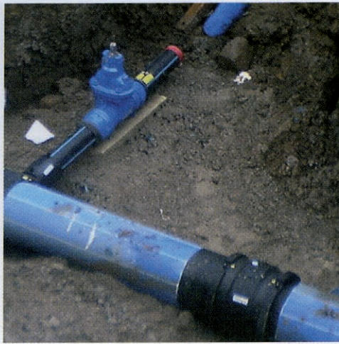
Den trasiga ledningen byttes ut med hjälp av styrd borrhning för vattenledningar enligt det nya systemet.
