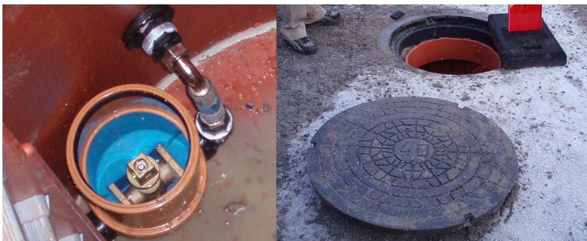
Figur 22. Till vänster syns en ventil med kopplingen till servisledningen. Höger bild illustrerar en av nedstigningsbrunnarna med borttaget lock. På locket syns de tre urspårningarna som ska passas in över de tre låspiggar som sitter i ramen.
