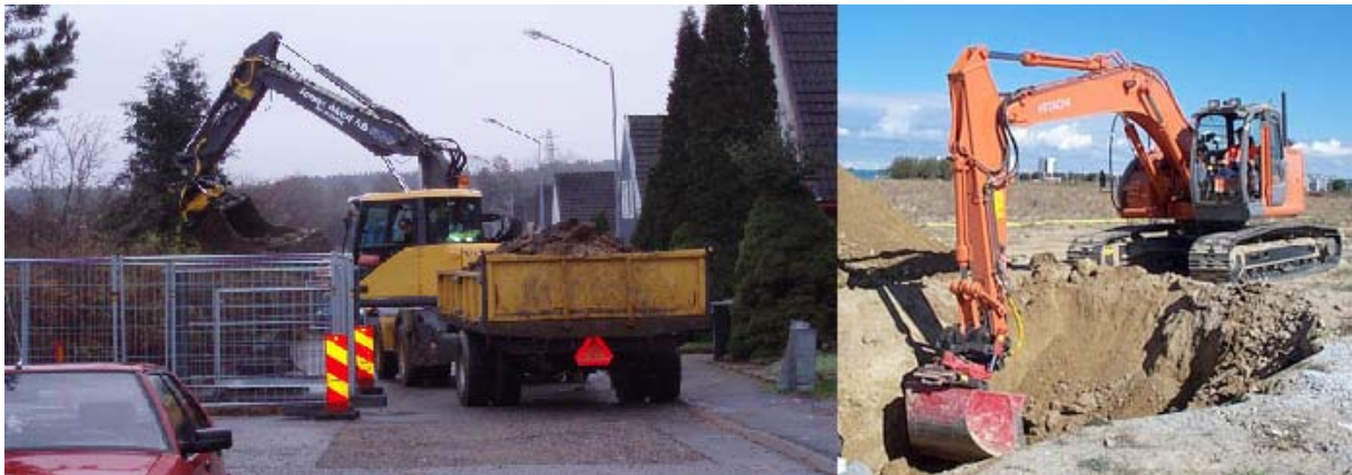
Figur 6. Vänster bild visar en grävmaskin på Lövängsvägen som precis har schaktat brunnsgrop, källa eget arkiv. Höger bild visar hur en ledningsgrav schaktas med grävmaskin, källa www.sundstorpsschakt.se
