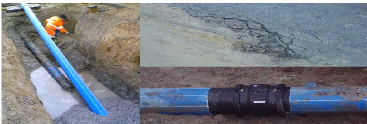
Figur 19. Bild till vänster visar schaktgropen som fick grävas extra för att kunna skarva ledningen där den fastnade. Övre högra bilden visar uppskjutningen i asfalten som uppstod vid ledningsdragningen. Nedre högra bilden visar skarven.
