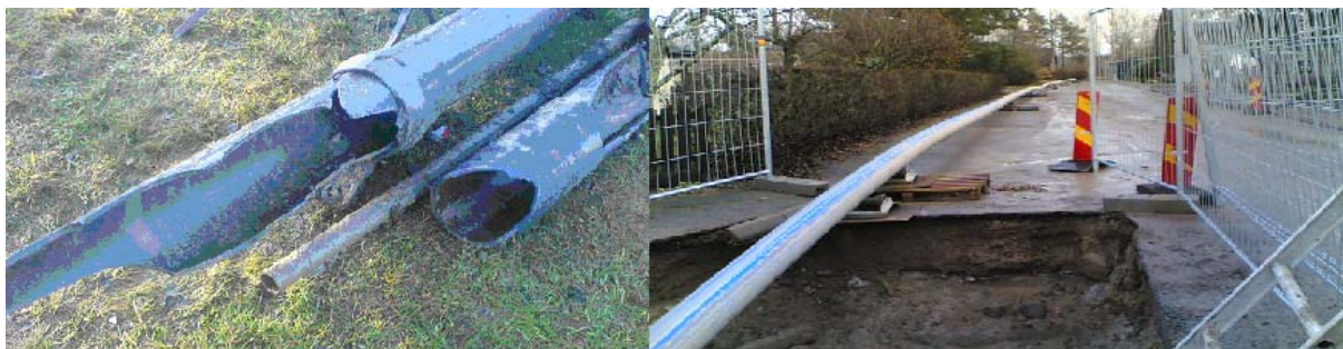
Figur 18. Vänster bild visar den trasiga ledningen och på högra bilden ser man hur ledningen dras om till den nya schaktgropen.
