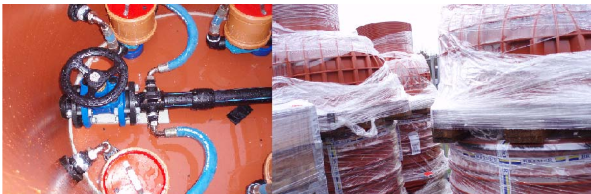
Figur 7. Vänster bild visar brunnen invändigt med avstängningsventilen. Höger bild visar brunnarna när de levererades till Lövängsvägen.
