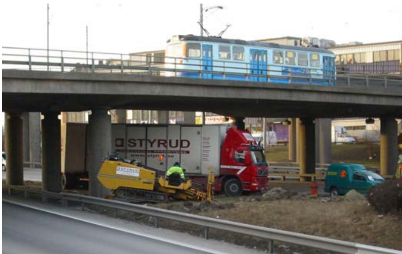
Figur 11. Borrning under högtrafikerad väg i Göteborg, källa www.styrud.se
