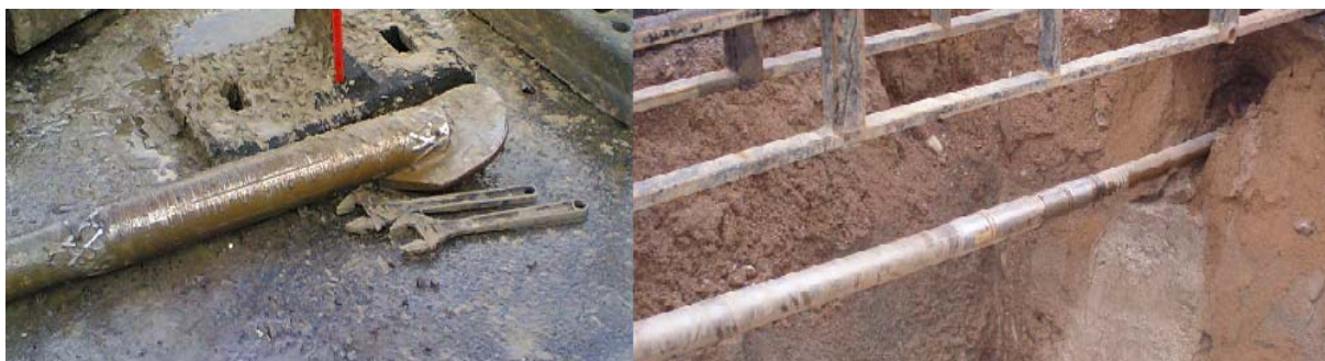
Figur 2. Vänster bild visar borrhuvudet och på höger bild ser vi hur borren med förlängningsstänger borrar in i startgropen.
