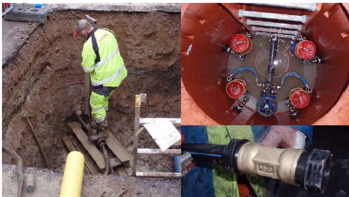
Figur 20. Vänster bild visar hur jordraketen riktas in mot servisgropen. Övre högra bilden visar en brunn med fyra servisventiler. Nedre högra bilden kopplingen mellan nya och gamla servisledningen.
