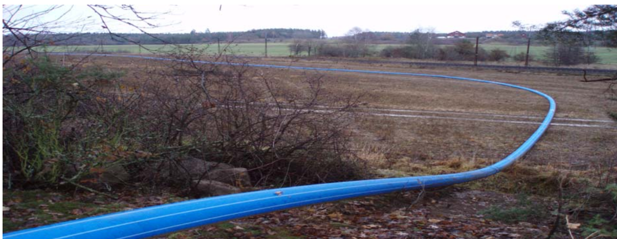
Figur 16. Den svetsade ledningen längs järnvägen.
