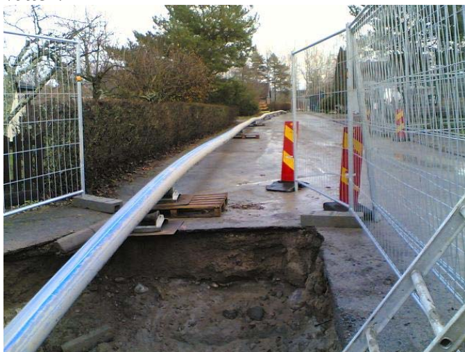
Figur 21. Bilden visar en av de få schaktgropar som fick grävas och hur man på sidan lätt kan ta sig fram med både personbil och grävmaskin.
